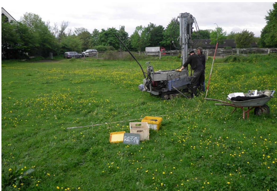
Messstelle KRB 14, Blick Richtung Süden.
