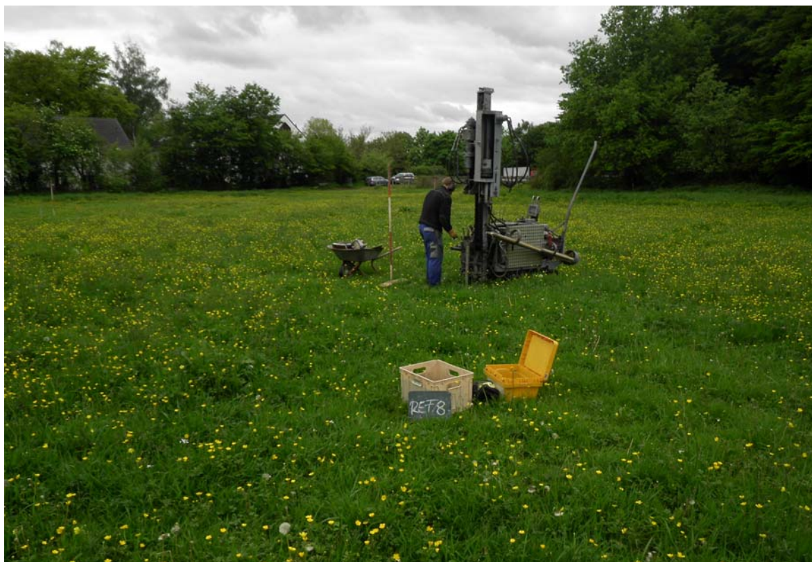
Messstelle KRB 8, Blick Richtung Süden.
